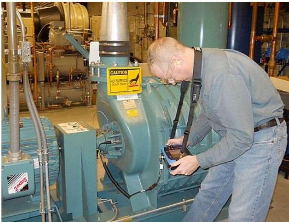
รูปที่ 23 การใช้เครื่องมือตรวจวัดความสั่นสะเทือนเครื่องจักร (ที่มา : บริษัท เทอร์โมสแกน จำกัด. 2561. สืบค้นจาก : http://www.thermoscan.co.th/vibration.html )
